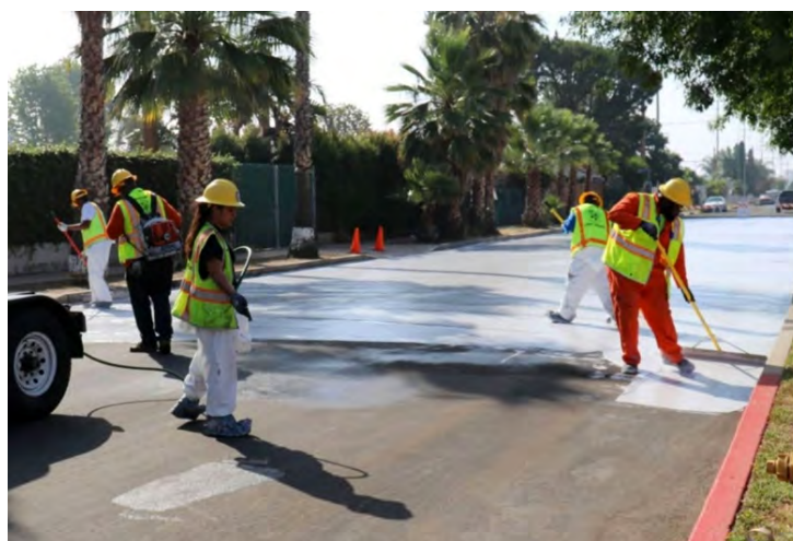
Figura 4. Los pavimentos fríos pueden reducir el calor de las ciudades. Beachy Avenue fue pintada, como parte de un proyecto piloto para probar un pavimento frío (Ayuntamiento de Los Angeles).
