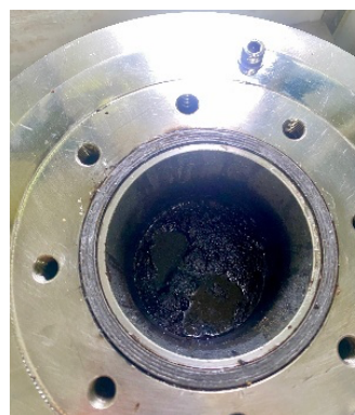
Figura 1. Co-carbonización hidrotérmica finalizada
