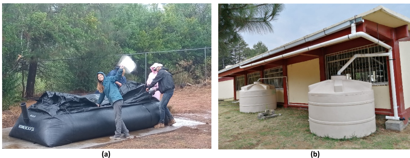
Figura 5. (a) Implementación de biodigestor en el COBAEM de San Francisco Pichátaro en la selección y capacitación de tecnologías. (b) Implementación de sistema de captación de agua en escuela secundaria (CONACYT, 2021).
