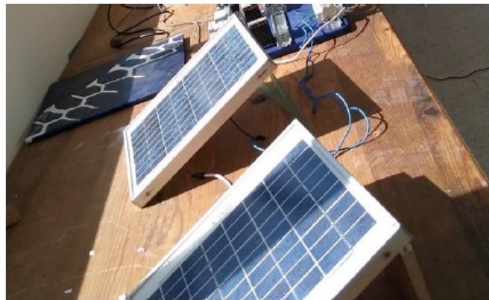
Figura 16. Paneles solares en paralelo para alimentar el sistema
