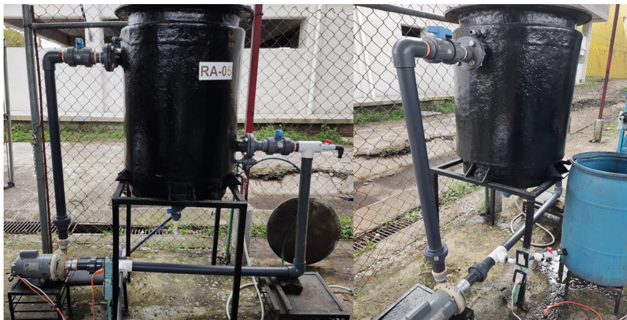
Figura 1 RABF acondicionado para el tratamiento del efluente de rastro
