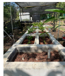
Figura 1. Distribución e instalación de tubería del humedal construido ITSM.
