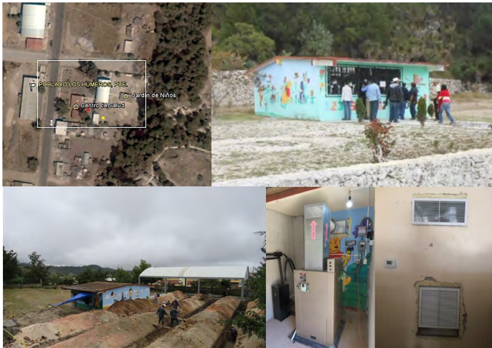
Figura 7. SBCG para Kínder, bomba vertical, GeoComfort
