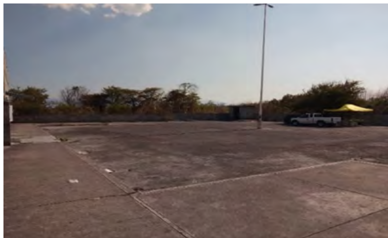
Figura 6. Parte posterior del establecimiento comercial
