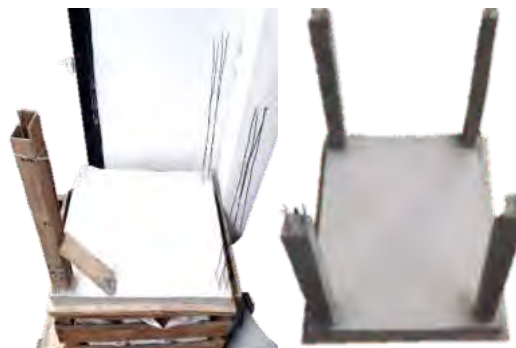
Figura 3: Molde de bloques de cemento y polvo, para construcción de las paredes del prototipo y base para el cimientado.
