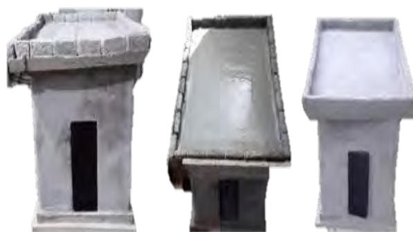
Figura 5. Etapas de la construcción del techo del prototipo.
